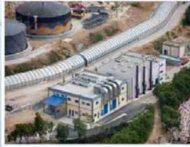
Α Κάλυψη Ανοικτού Καναλιού Λυμάτων Β Επέκταση Μονάδας Συμπαγωγής με Καύσιμο Βιοαέριο Ισχύος 4,25 MWε
