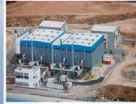
Νέα Μονάδα Συμπαγωγής με Καύσιμο Φυσικό Αέριο Ισχύος 12,9 MWε
